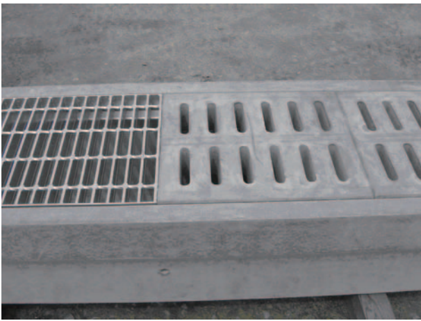
図3 リサイクルCFRP強化コンクリート製グレーチング (右側)
